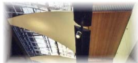
Lichtgewicht dubbelwandig plafond element Carbon/ fenol sandwich laminaat > 18 m 2 , totaal gewicht 175 kg, inclusief ophangingframe. Gehele constructie is zelfdragend en kan ca. 2 personen dragen
